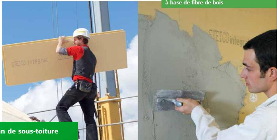
**Panneau pare-pluie, écran de sous-toiture et support d'enduit**
